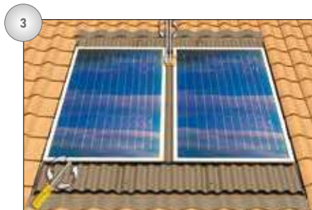
3) Posizionamento e fissaggio dei collettori sulla struttura e montaggio della raccorderia.
