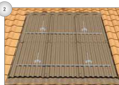
2) Ancoraggio delle convesse e della carpenteria di fissaggio dei collettori.
