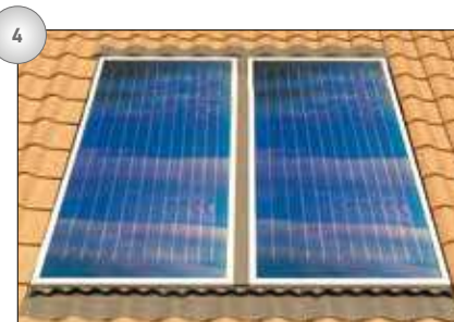
4) Finitura della posa e riposizionamento della copertura in eccesso rimossa.
