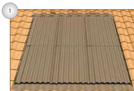
1) Rimozione della carpenteria e posizionamento delle convesse nello spazio necessario all'installazione.
